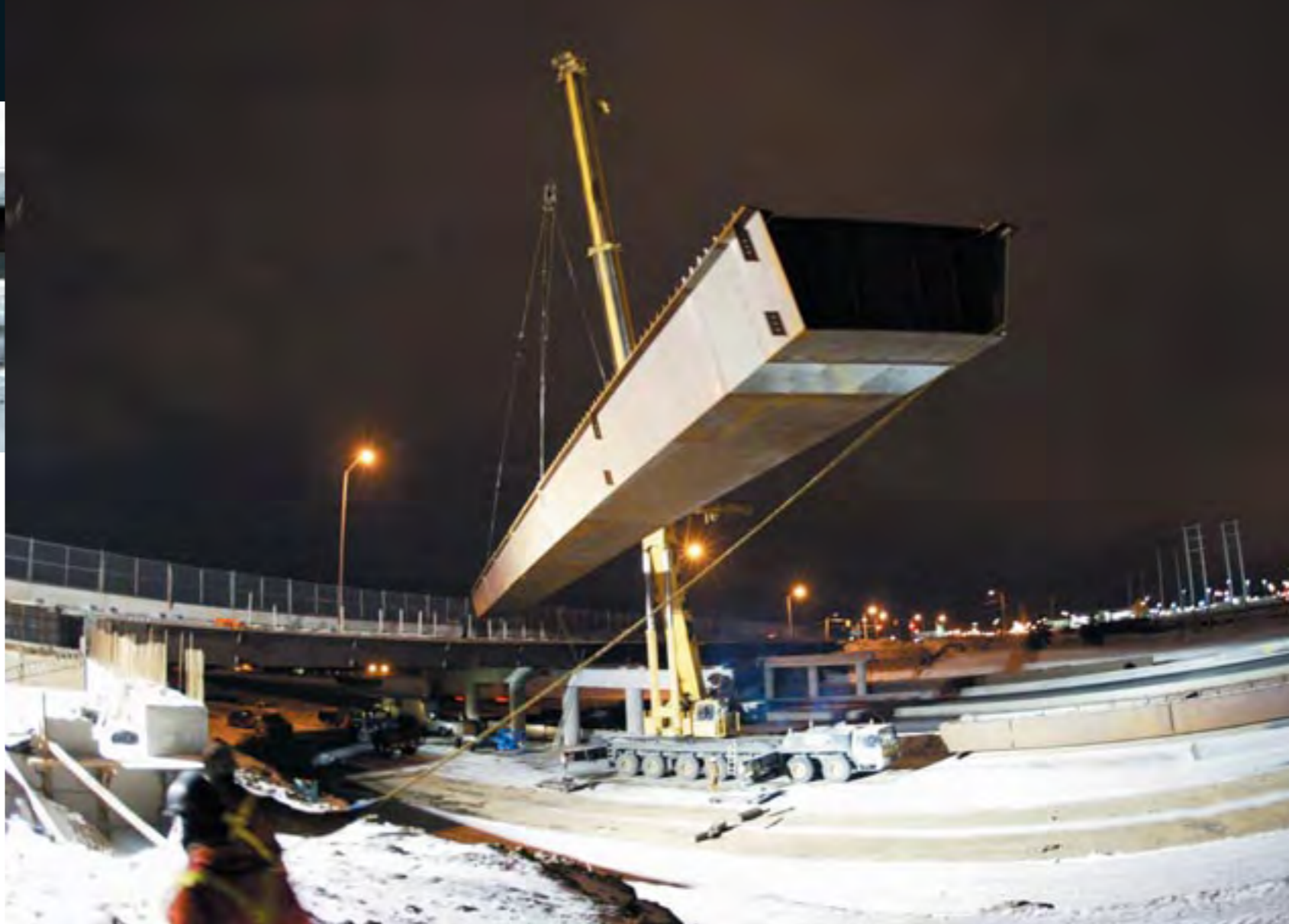
Propriétaire actuel: Région de Peel et Ministère des transports de l'Ontario Ingénieur en structures: Giffels Associates Ltd. Entrepreneur général: Fermar Paving Sous-traitant de structure: Soncin Construction Fabricant d'acier: Central Welding & Iron Works
